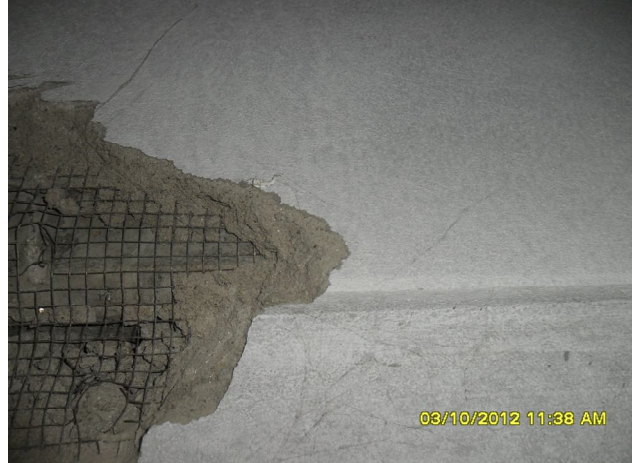
Hình 4. Nứt giữa vị trí tường xây với kết cấu chịu lực
