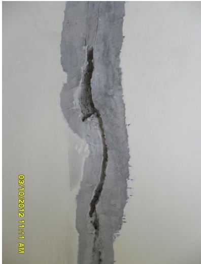
Hình 4. Nứt giữa vị trí tường xây với kết cấu chịu lực
