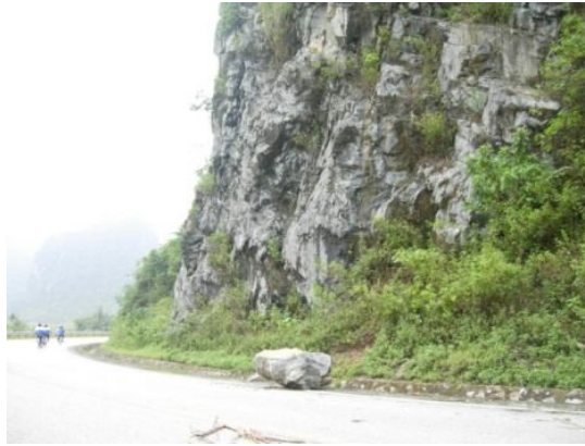
Ảnh 2. Sụt đá tại km 877+700 đường HCM (ngày 03/10/2009)
