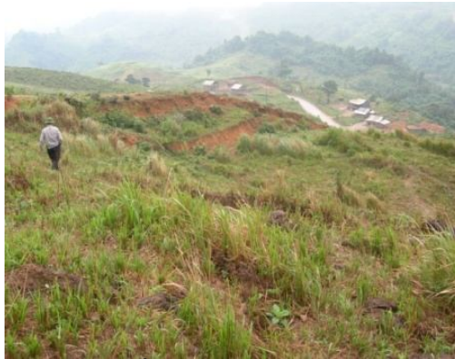
Ảnh 5. Trượt đất đá tại km 127+000 đường 12A (ngày 10/11/2006)
