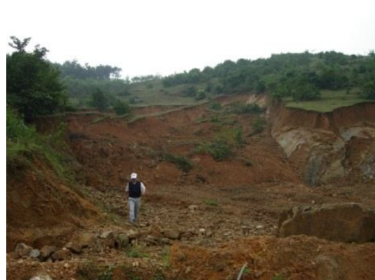
Ảnh 4. Sụt đất đá tại Km 859+419 đường HCM (ngày 17/12/2008)
