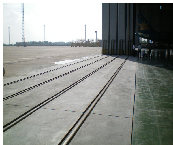
Hình 6. Vùng cửa hangar sau khi hoàn thành sửa chữa
