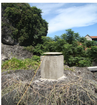
Hình 3. Móc chuẩn xây trên núi đá
