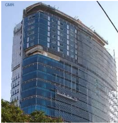
(a) Mặt dựng tường kính hệ Stick
