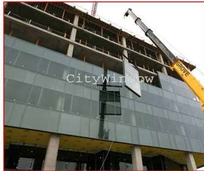
(b) Mặt dựng tường kính hệ Unitized
