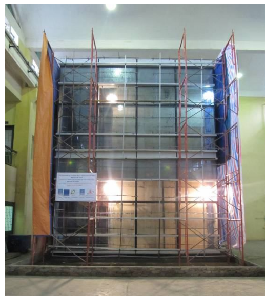
b) Thí nghiệm mặt dựng tường kính của công trình tòa nhà Petroland (Hồ Chí Minh)
