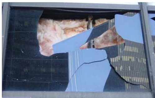
(c) Kính bị phá hoại dưới tác dụng của vật thể bay trong cơn bão
