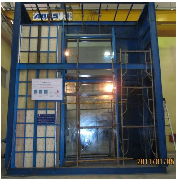
a) Thí nghiệm mặt dựng tường kính của công trình tòa nhà PV GAS (Hồ Chí Minh)
