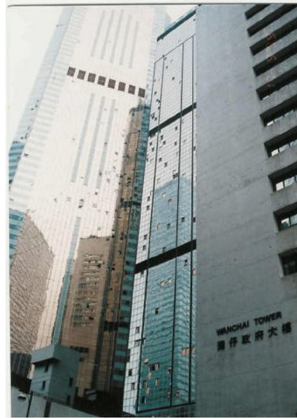
(b) Mặt dựng tường kính của một nhà cao tầng tại Hồng Kông bị phá hoại
