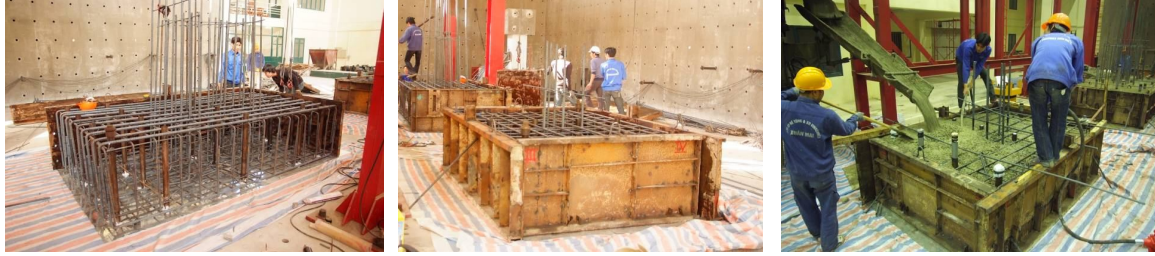
Hình 1. Thi công móng
