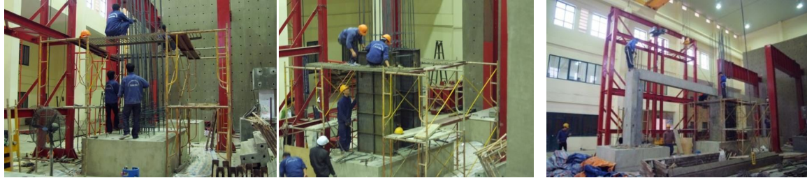
Hình 2. Thi công dầm, cột, vách
