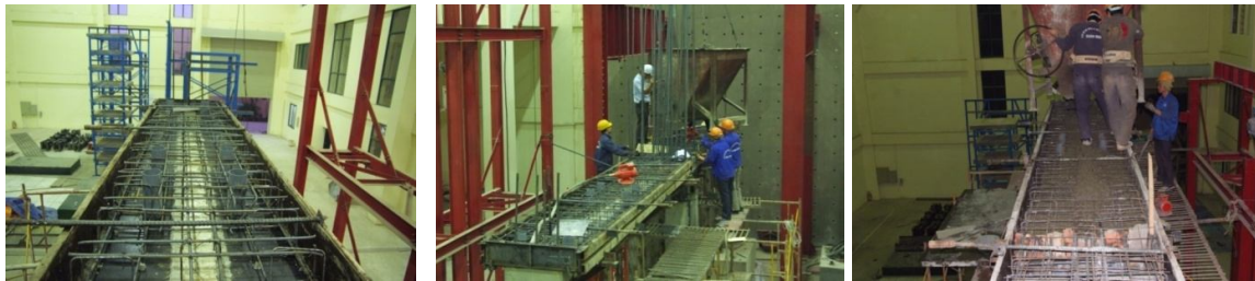
Hình 3. Thi công sàn tầng 1
