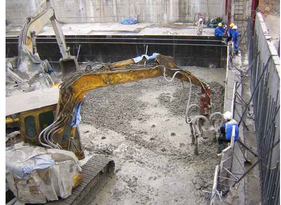
Hình 4. Đảm bê tông bằng đầm rung chuyên dụng tại đập CVC Sesan 3
