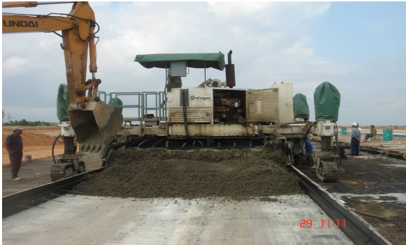
Hình 7. Máy rải bê tông liên hợp SP- 500 thực hiện công tác trải và xoa hoàn thiện (ACC)
