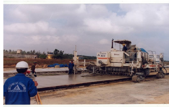
Hình 7. Máy rải bê tông liên hợp SP- 500 thực hiện công tác trải và xoa hoàn thiện (ACC)
