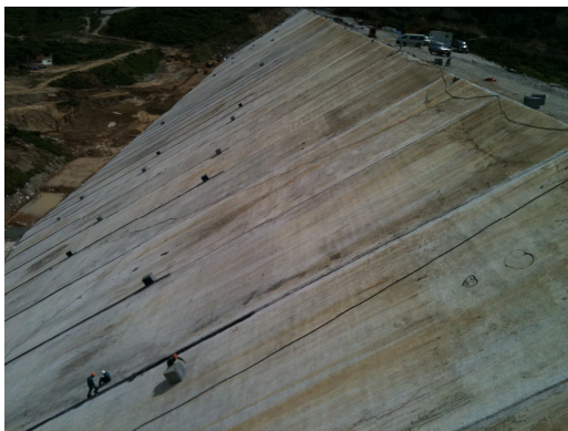
Hình 5. Thi công đập CFRD Đập An Khê - Kanak
