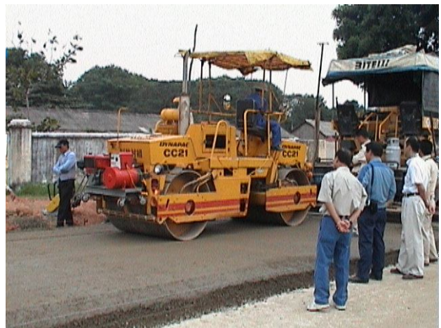
Hình 8. Thi công thử nghiệm mặt đường bê tông đầm lăn - IBST thực hiện 2001
