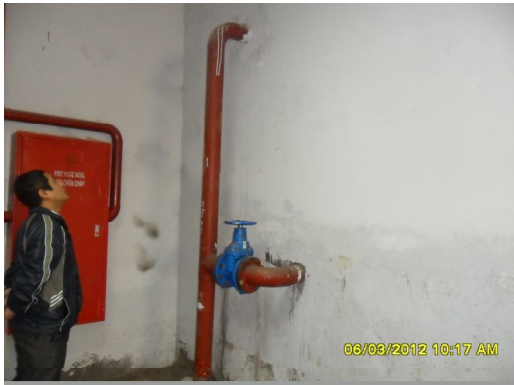
Hình 5. Thấm bể nước tại vị trí lỗ kỹ thuật
