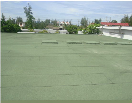
Hình 1. Mái được chống thấm bằng màng bi tum
