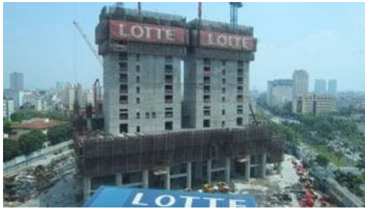
Hình 4. Hai phần kết cấu lõi (Core) của tòa nhà Lotte đang thi công
