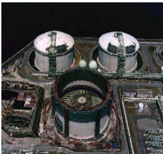
Hình 2 BTTL trong thi công kết cấu ứng suất trước của bể chứa ga tại Osaka
