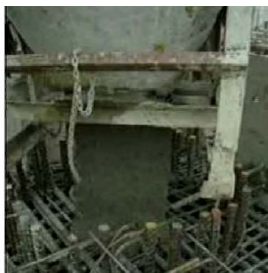
Hình 4 Thi công BTTL tại nút dầm - cột nhà 34 tầng - T34 Dự án Trung hoà (VINACONEX)
