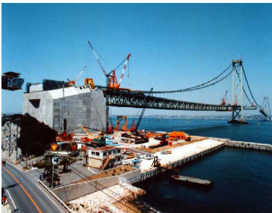
Hình 1 Thi công bê tông tự lèn xây dựng cầu Akagashi - Nhật bản
