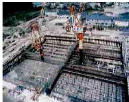
Hình 1 Thi công bê tông tự lèn xây dựng cầu Akagashi - Nhật bản
