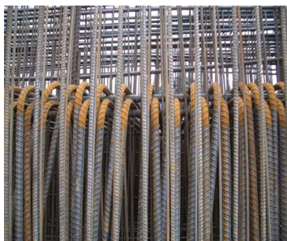
Hình 3 Kết cấu thép dầm - cột nhà 34 tầng – T34 Dự án Trung hoà (VINACONEX)
