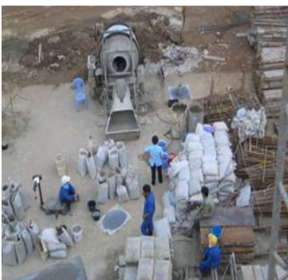
Hình 4 Thi công BTTL tại nút dầm - cột nhà 34 tầng - T34 Dự án Trung hoà (VINACONEX)
