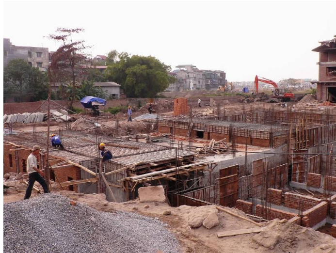
Hình 5. Thi công móng nổi tại khu đô thị mới Bắc Hà
