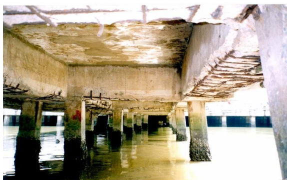
Hình 1. Cảng Thương vụ - Vũng Tàu sau 15 năm sử dụng
