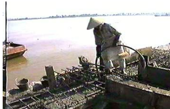
b. Công trình nâng cấp cảng Cửa Cấm - Hải Phòng
