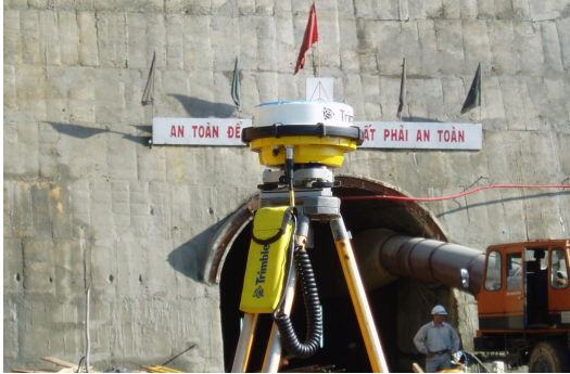
Hình 6a. Sử dụng hệ thống định vị GPS để dẫn tọa độ vào sát cửa hầm
