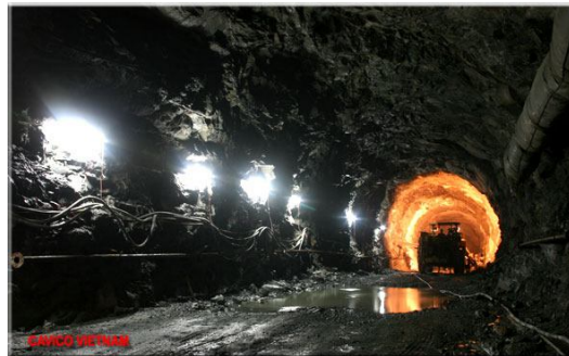
Hình 4. Thi công đường hầm bằng phương
