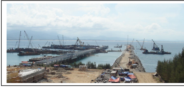
Hình 7. Cầu dẫn của cảng xuất sản phẩm và bộ đặt máy để quan trắc lún
