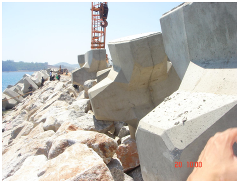
Hình 6. Lắp đặt Acropode trên mặt đê
