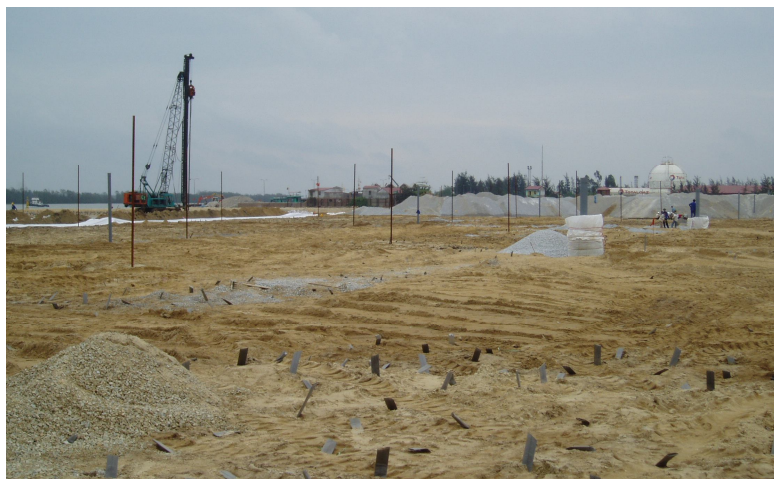
Hình 1. Các mốc đo lún trên mặt bằng dự án xây dựng kho cảng container Chùa Vẽ, Hải Phòng
