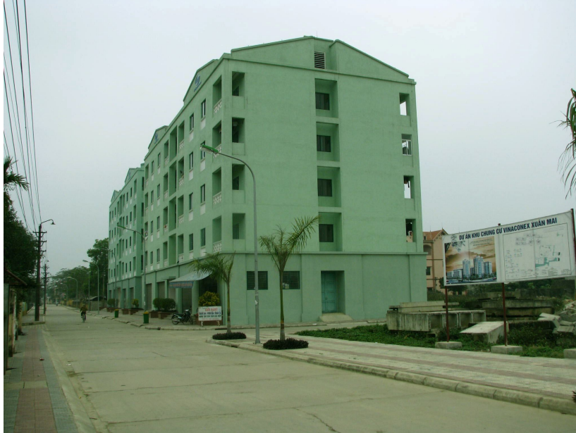
Hình 1. Nhà lắp ghép 5 tầng, Vinaconex Xuân Mai, Chương Mỹ, Hà Tây
